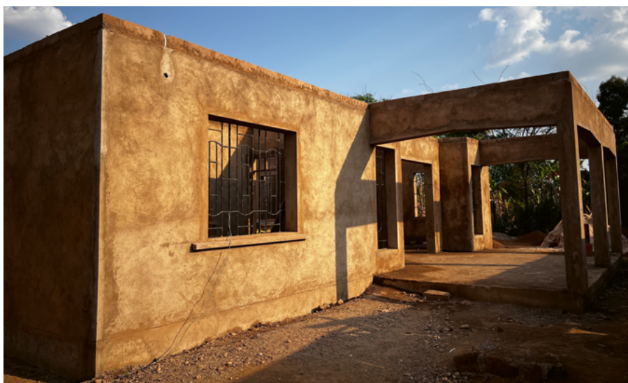
Hier entsteht am Kabanga Referral Hospital (Kigoma Region) die dritte Augenklinik des Projektes.
